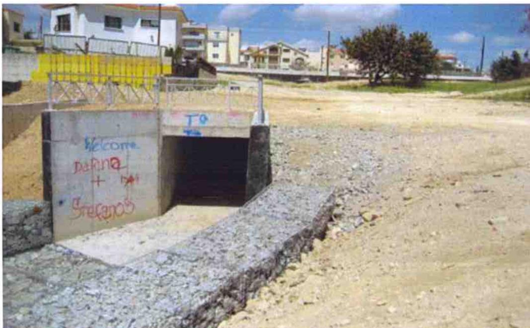
**Εικόνα 2-5: Υφιστάμενος κλειστός οχετός διαστάσεων  $2,2 \times 2,5\text{m}$**
