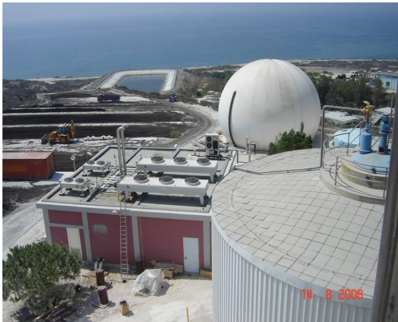
Πανοραμική όψη: Χωνευτή, αεριοφυλακίου και κτηρίου Γεννητριών στον βιολογικό σταθμό του ΣΑΛΑ στην Μονή.
